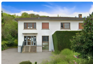
CMP* 5 4 rue des Roses - Clouange
