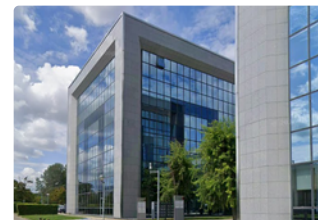
Passerelle Psy 2 rue Augustin Fresnel - Metz
