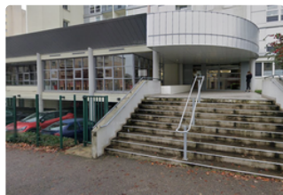
Structure Intermédiaire d'Accompagnement Soignant (SIAS) Metz Sablon
